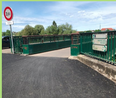
Pont Sainte-Suzanne Fini les bourrelets inconfortables.
