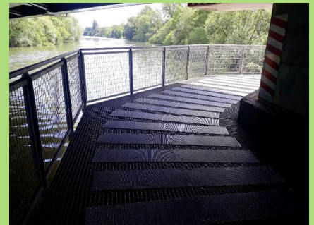
Passerelle sous autoroute Pose de platelage
