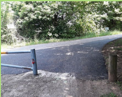
Suppression d'une marche Croisement EV6 - Exincourt
